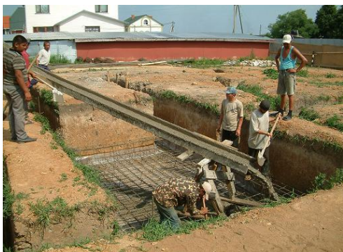
Устройство фундаментов жилого дома.
