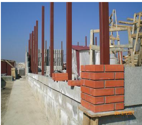
Стойки каркаса из трубобетона.
