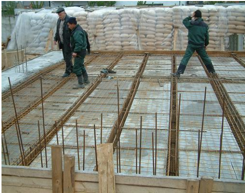
Устройство перекрытия первого этажа.
