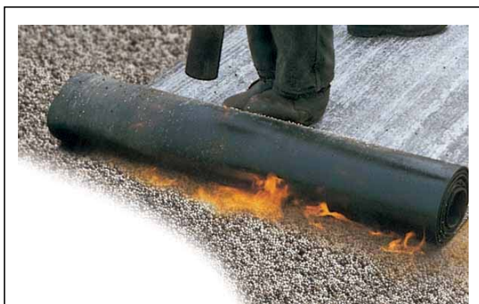
Рис. 2.11. Монтаж мягкой гидроизоляции поверх выравнивающей смеси NEVOLIT (материалы с сайта www.poraver.com )
