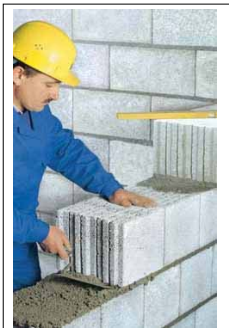
Рис. 2.13. Укладка блоков из Поравера на цементной связке (материалы с сайта www.poraver.com )
