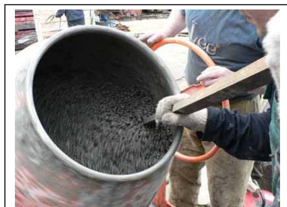
Рис. 2.9. Изготовление легкого бетона непосредственно на строительной площадке из пеностеклянного гравия Пеноситал (фотография с сайта www.penosytal.ru )
