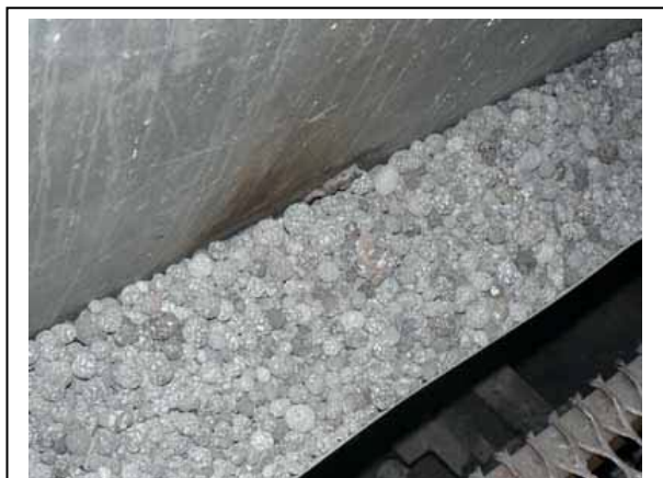
Рис. 2.7. Теплоизоляция технологического оборудования пеностеклянным гравием Пеноситал (фото с сайта www.penosytal.ru )
