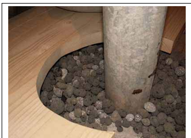
Рис. 2.2. Засыпка пеностеклянным гравием Пеноситал межэтажного перекрытия в области топочной трубы (фото с сайта www.penosyital.ru )
