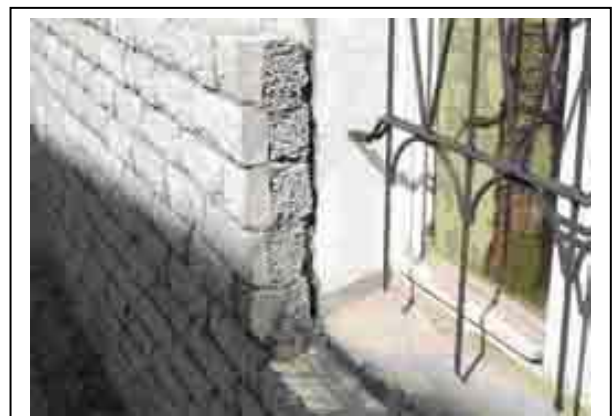
Рис. 2. Фотография фрагмента конструкции с облицовочно-теплоизоляционными кирпичами. . Фото с сайта http://articles.stroybm.ru/komfort/20000824163600/index.html
